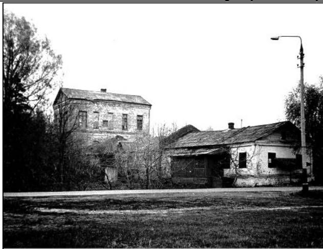
Усадьба "Таболво". Хозяйственная постройка. Общий вид с северо-запада, фото 1979 г.
