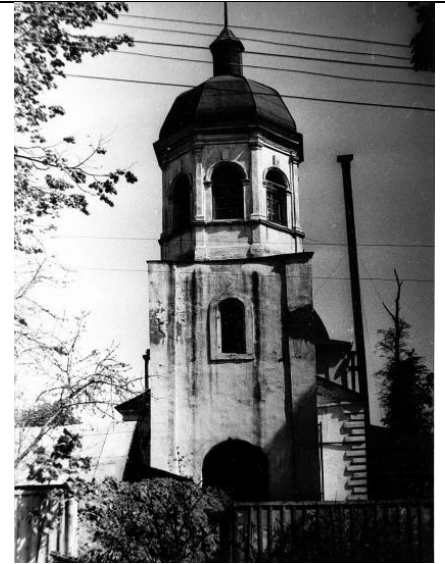
Троицкая церковь. Общий вид колокольни. Западный фасад, фото 1979 г.
