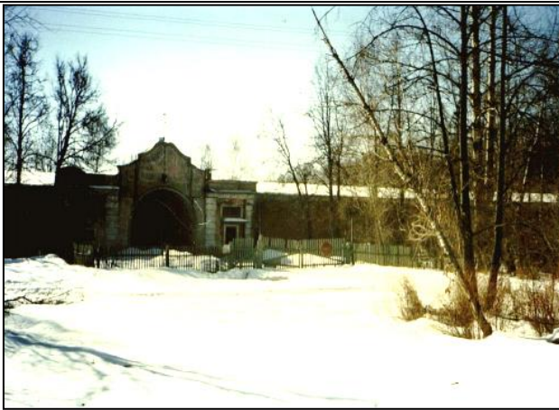
Памятное место "Бутовский полигон". Здание казармы – предполагаемого конного двора усадьбы, фото 1996 г.
