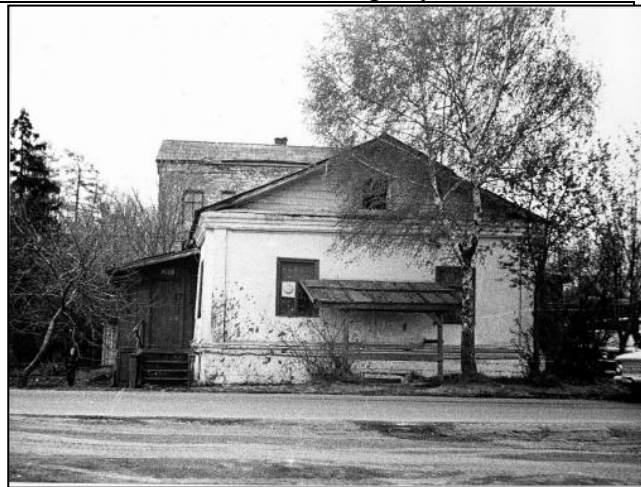
Усадьба "Таболво". Хозяйственная постройка. Вид с запада, фото 1979 г.
