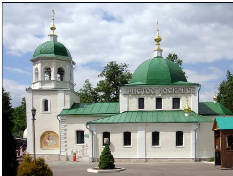
Троицкая церковь, фото 2019 г.
